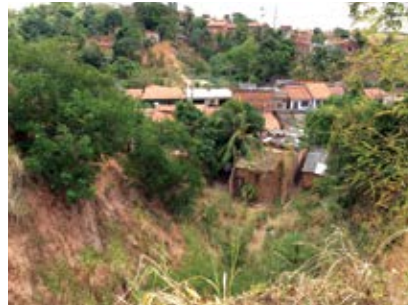
Casas em área de risco geológico Houses in geological risk areas
