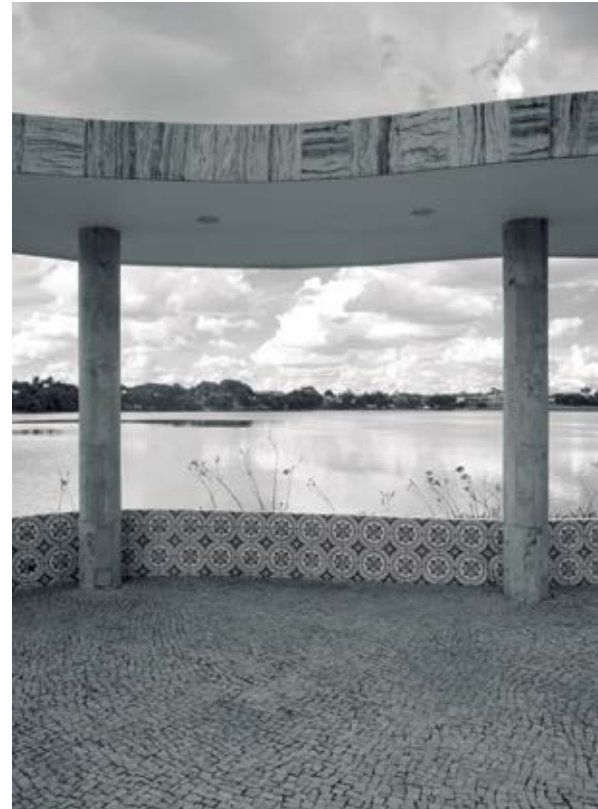
Restauração Casa do Baile – 2012/2013
